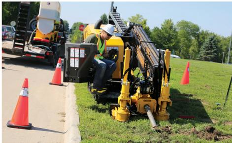
**LA BONNE PUISSANCE POUR LA BONNE EMPREINTE.** La foreuse D20x22 S3 affiche une augmentation considérable de puissance et de couple de rotation par rapport à la version précédente, la D16x20 Série II, ce qui la rend parfaitement adaptée à l'installation de câbles, de fibres et de tuyaux de manière efficace et rentable.
